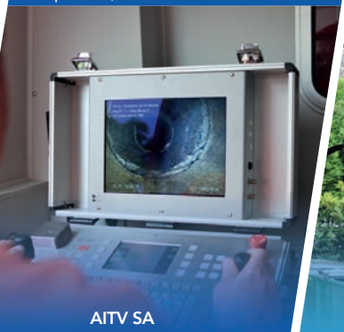
Inspection, détection et réhabilitation
